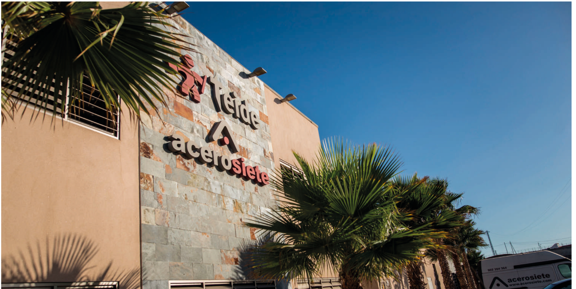
Entrada de la fábrica de Prefabricados Teide en Las Eras, Arico.
