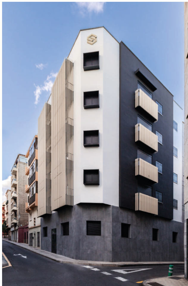
Edificio de 15 viviendas, Santa Cruz de Tenerife. 2023
