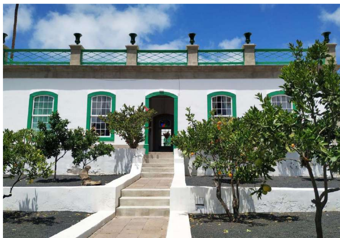
Fachada de La Casa de los Naranjos.
